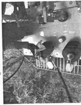
ที่วัดแรงดันไฟฟ้า Bushing ด้านแรงสูง
