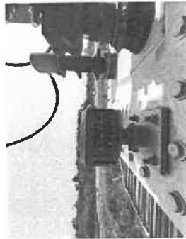
เทอร์โมมิเตอร์อุณหภูมิของน้ำมัน : Oil Temp
